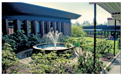
Nya lokaler 2005, kontorsbyggnaden.
